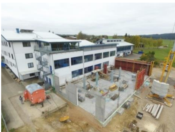
Abbildung 5: Neubau einer Produktionshalle der ERO-Führungen GmbH Erich Rothweiler & Söhne, Bildquelle: ERO-Führungen GmbH
